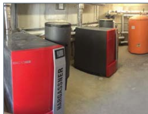
Chaudières EcoPK 2x110 kW avec deux extracteurs type RAS.
