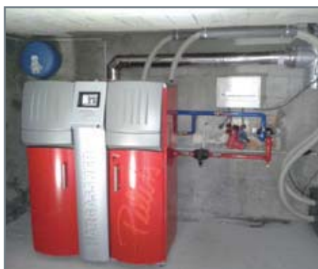
Chaudière HSV de 16 kW avec commutation automatique double RAPS
